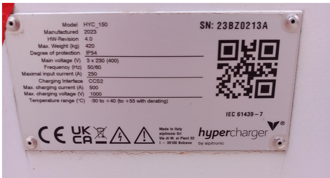
Cartel de especificaciones técnicas del cargador y nº de serie.
